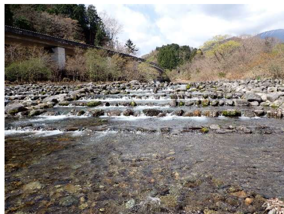
図8. 全断面型魚道の例
