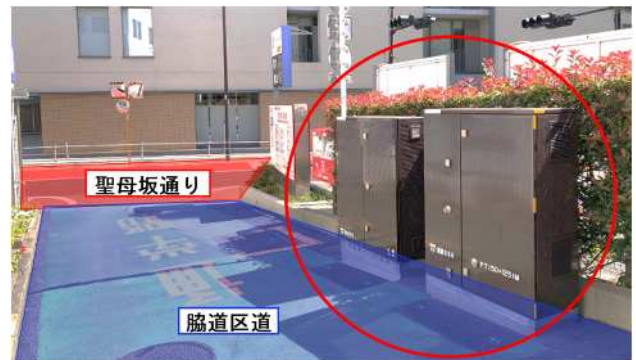
写真-3 脇道区道上の地上機器設置状況
