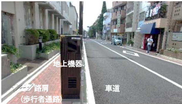
写真-2 道路本線上の地上機器設置状況
