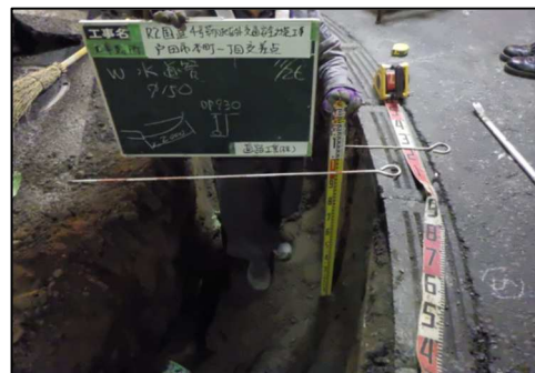
写真-3 水道管の確認（土被り:930mm）
