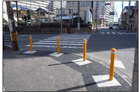
写真4 ボラード設置完了箇所の状況
