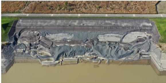
図-4 荒川第一調節池被災状況
