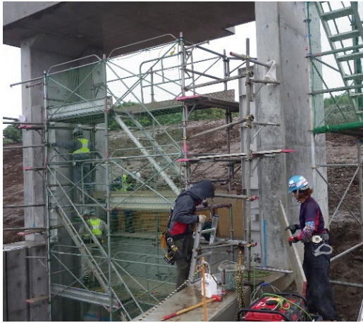
写真2 ゲート設備工事の様子（鎌庭排水樋管）。
