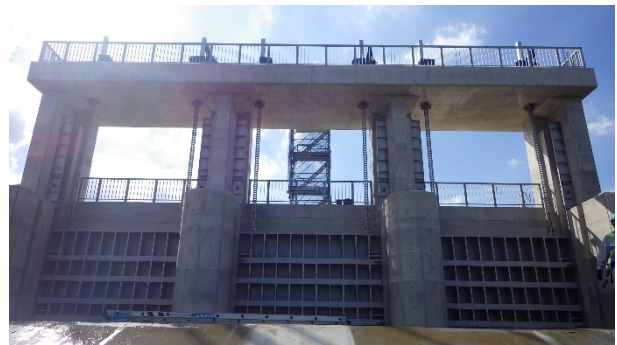
写真5 据付完了の様子（豊坂排水樋管）。
