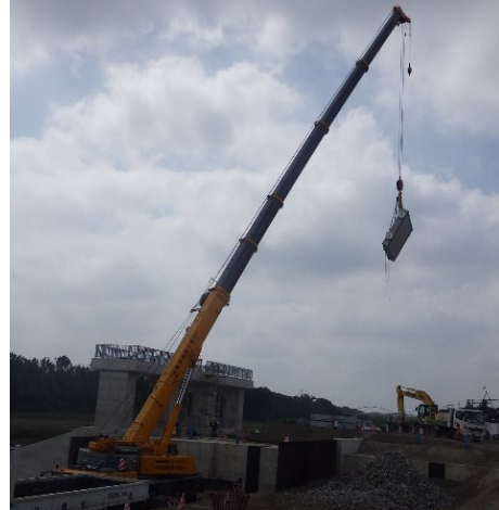
写真4 扉体据付の様子（豊坂排水樋管）。
