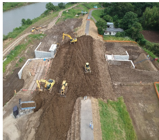
写真-1 築堤工事の様子(鎌庭排水樋管)
