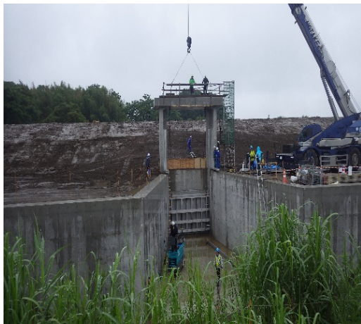
写真3 据付完了の様子（鎌庭排水樋管）。
