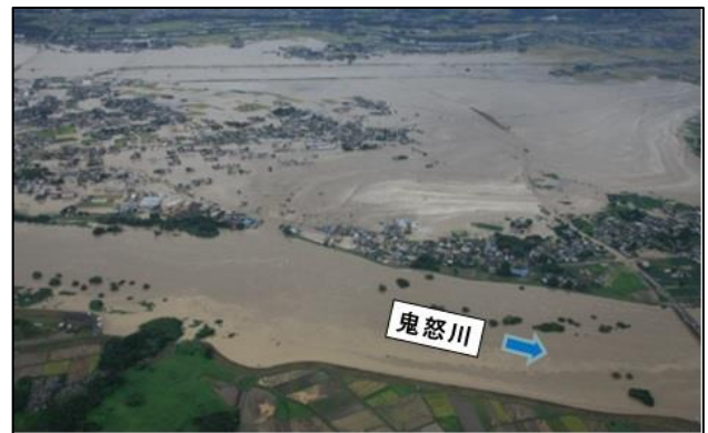
(写真-1) 決壊箇所（常総市三坂町）
