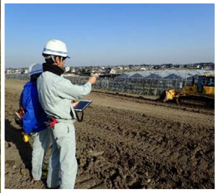
休日ゲームセンターにて タブレットによる 締固め状況確認
