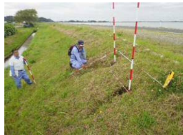
堤防点検状況
