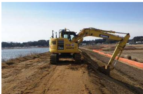
堤防補修状況
