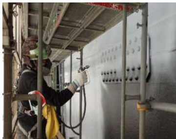
常陸川水門塗装状況
