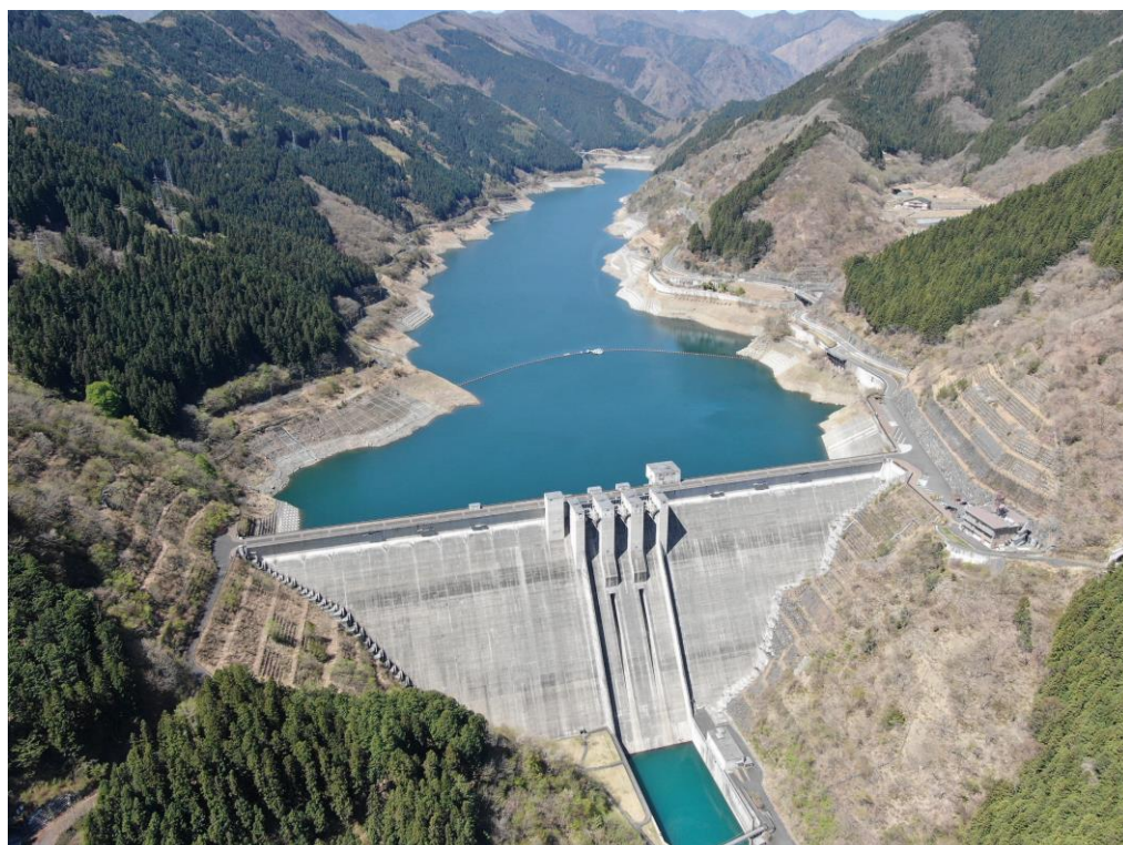
滝沢ダム上流域の状況（令和3年4月15日撮影）
