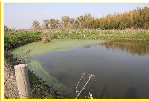
④ 水位が高く当面見守る箇所
