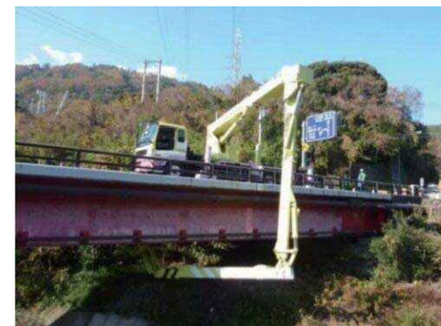
橋梁点検車による点検状況
