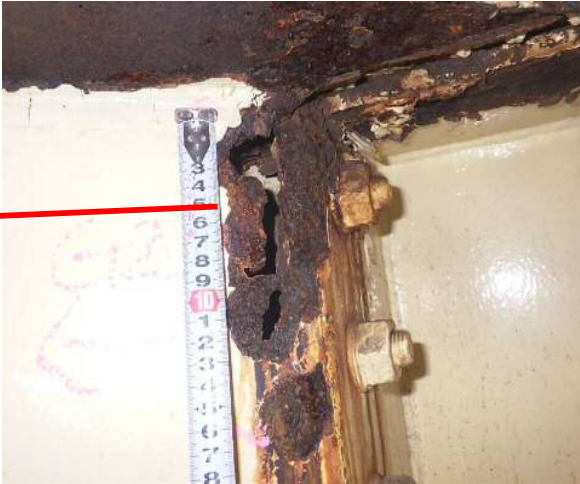
損傷部拡大
