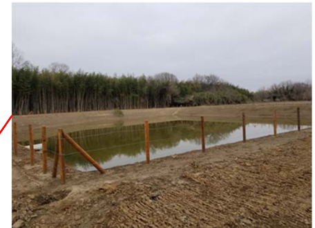
2019下池掘削箇所
