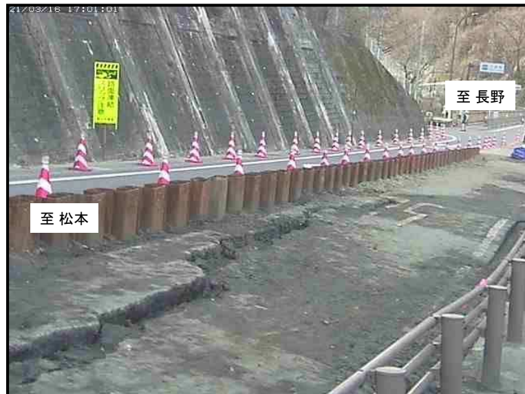
・鋼矢板打設完了後 3月16日撮影
