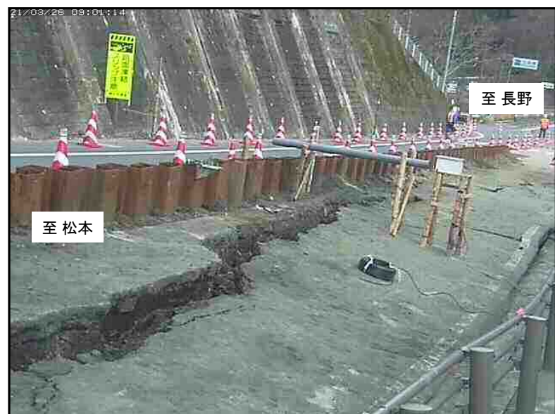
・鋼矢板打設完了後 3月26日撮影
