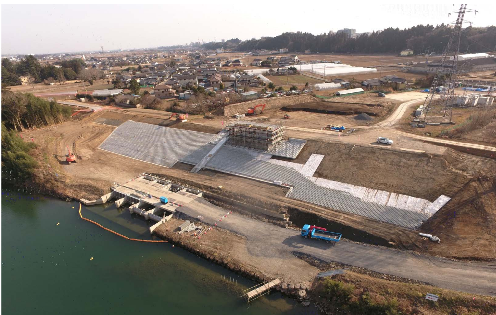
作品タイトル：護岸ブロックでテトリス 撮影者コメント：一つ一つコツコツと 撮影日・撮影場所：2021/1/19 水戸市渡里町地先 撮影者会社名：金成重機建設(株) 撮影者：佐藤 和摩
