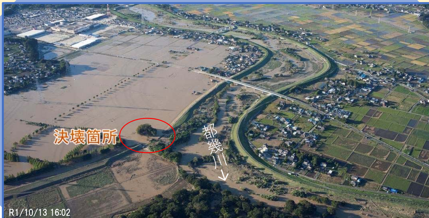
都幾川右岸0.4k付近（埼玉県東松山市早俣地先）の被災状況
