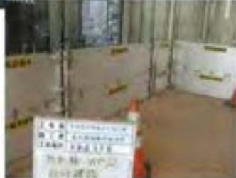
庁舎の周囲に整備された浸水防止板の様子（常総市）
