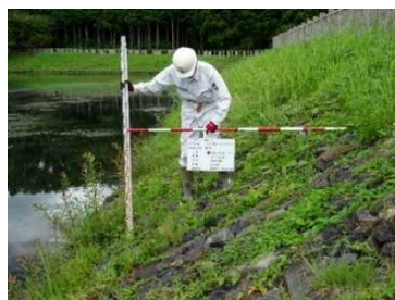
管理者によるため池の点検
