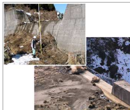
砂防施設点検による 噴火後の危険度検討
