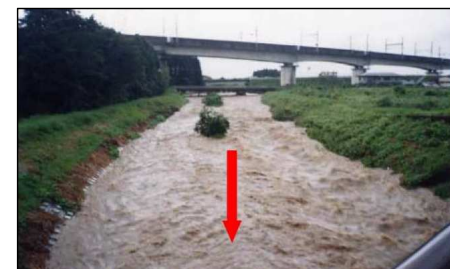
写真②熊川旭橋付近（H10.8洪水）
