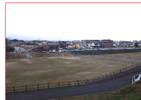
調整池の整備事例（那須塩原市）
