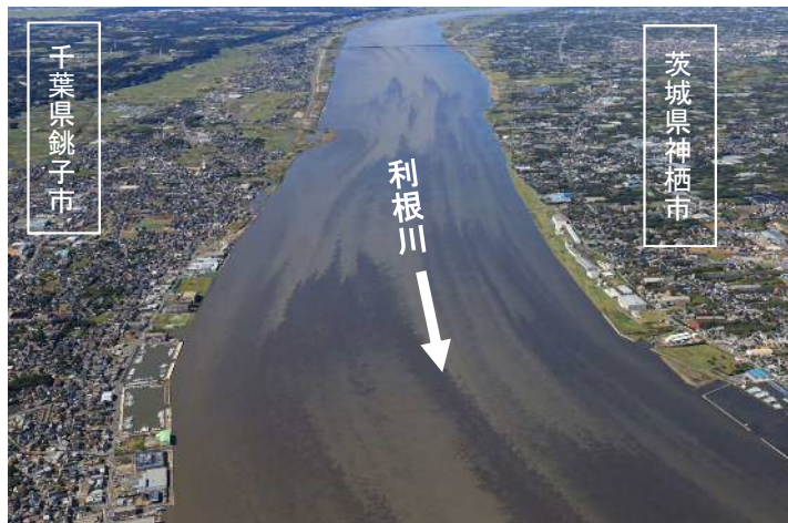
利根川の出水状況(令和元年10月台風19号)
