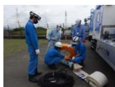
ポンプの組立
