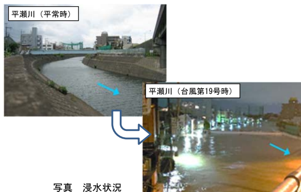
写真 浸水状況
