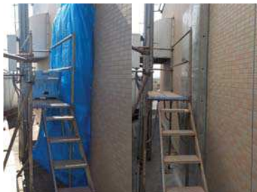
施設鋼製パネルの施工状況
