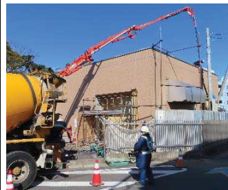
耐水化の施設扉設置工事を実施
