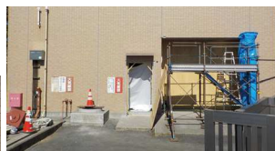
施設鋼製扉の施工状況
