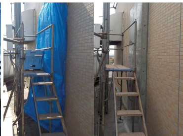
施設鋼製パネルの施工状況
