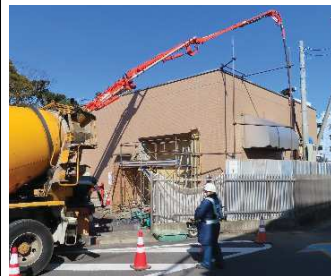
耐水化の施設扉設置工事を実施
