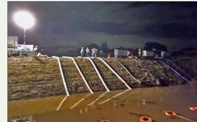
台風19号の影響により浸水被害が生じている栃木県小山市の要請を受け、令和元年10月13日にポンプ車1台（60m<sup>3</sup>/s）を派遣し、永野川と巴波川（うずまがわ）の合流点付近（小山市押切地区周辺）において排水支援を行いました。これにより、約36,000立方メートルの排水作業を実施しました。
