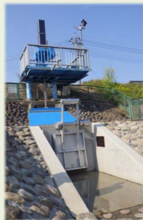
岩鼻樋管 フラップゲート化
