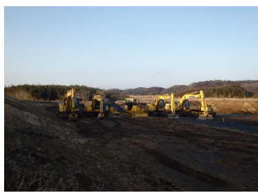
【堤防工事開始】 撮影者会社名・撮影者：(株)梅原工務店 佐藤 祐樹
