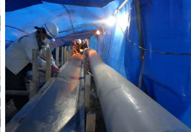
【縦帯箇所のコンクリート仕上げ】 撮影者会社名・撮影者：前橋地建(株) 萩原 樹
