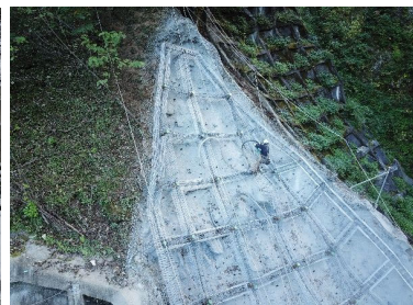
【法面職人】 撮影者会社名・撮影者：丹澤建設工業(株) 保坂 裕也
