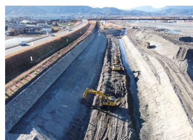
【工事現場が変わる】 撮影者会社名・撮影者：湯澤工業(株) 大西 唯善
