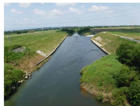
改築後：平成29年7月
