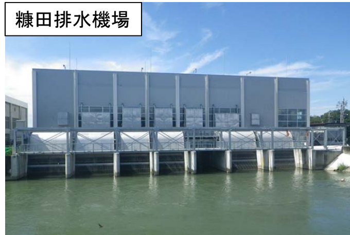
糠田排水機場
