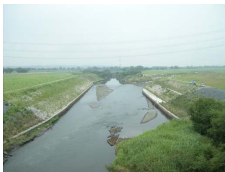
改築後：平成28年7月
