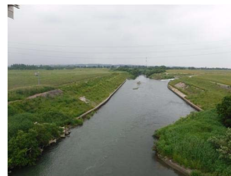
改築後：平成30年7月
