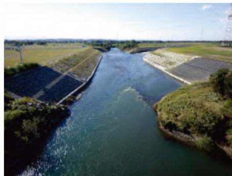
改築後：平成27年10月
