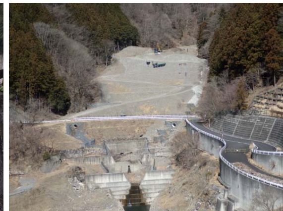
入波沢受入地の状況写真 平成31年3月18日撮影
