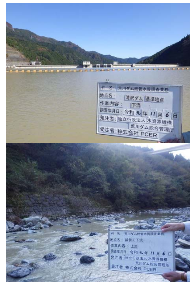
台風第19号出水後25日後の貯水池内と下流河川の状況
