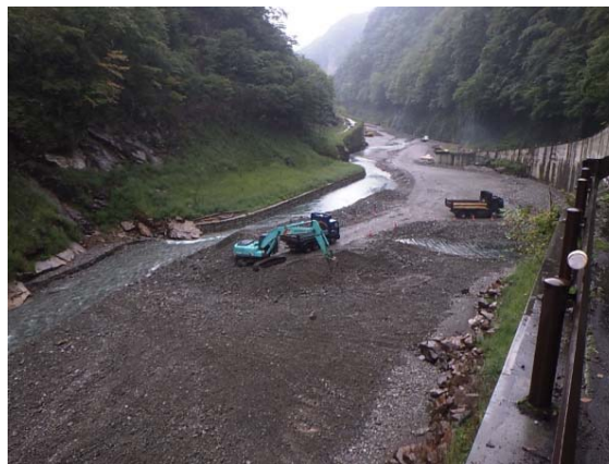
貯砂ダムの堆砂除去作業 平成30年10月3日撮影
