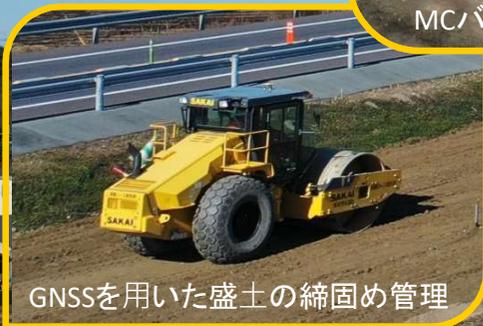
GNSSを用いた盛土の締固め管理
