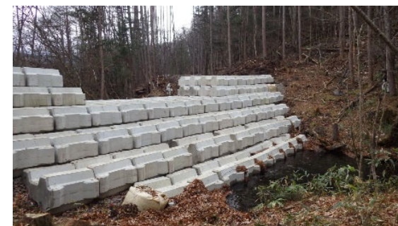
コンクリートブロックによる不透過型砂防堰堤の施工事例 国土交通省 中部地方整備局 多治見国道事務所管内 鹿ノ瀬川
