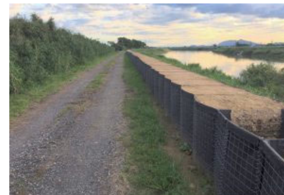
箱型鋼製枠による堤防嵩上げ工 出典:太陽工業株式会社HP
