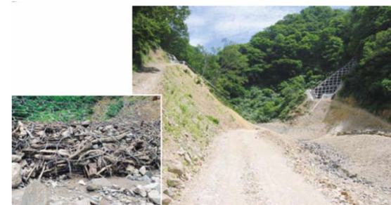
流木対策の事例（左：鋼製牛柵（新燃岳）、右：ワイヤネット）
