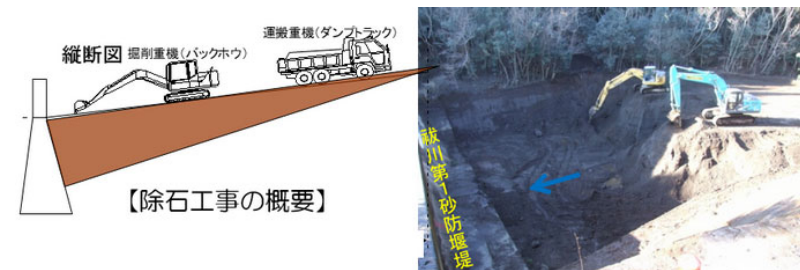
図 既存砂防堰堤における緊急除石の例 国土交通省 九州地方整備局 宮崎河川国道事務所管内 祓川(高原町)
