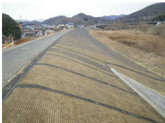
イノシシ対策ネット施工状況
