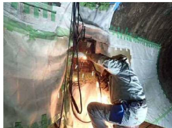
導水管亀裂補修緊急対応
