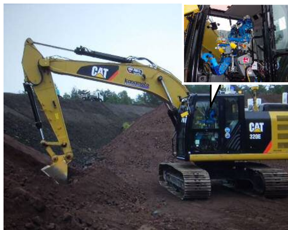
ICT建機での無人化施工状況
