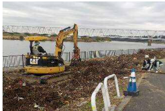
塵芥処理施工状況
