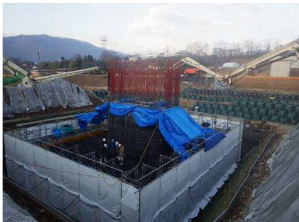
P8橋脚施工状況
