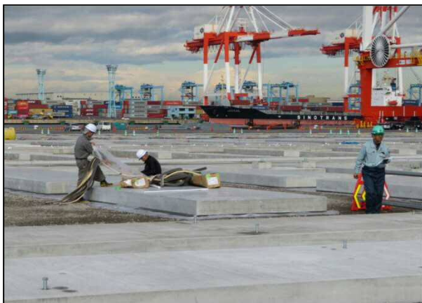
施工状況(舗装工PPC版据付)
