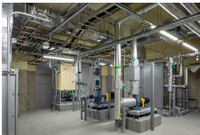
機械室完成状況
