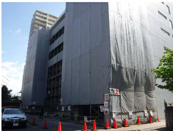
外部架構施工状況
