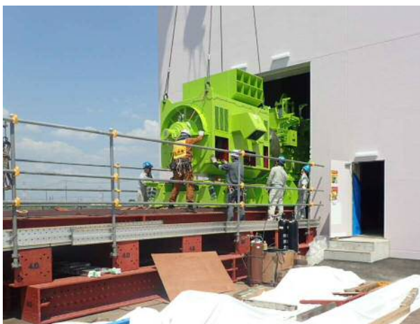
発電機組立状況
