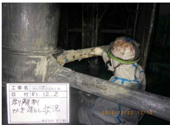
既設塗膜剥離施工状況
