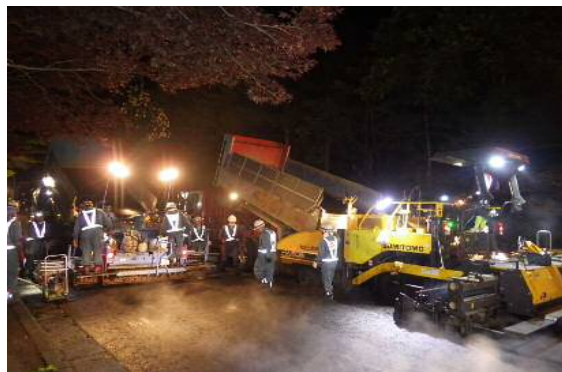
一般国道138号山中湖村 切削オーバーレイ工事施工状況
