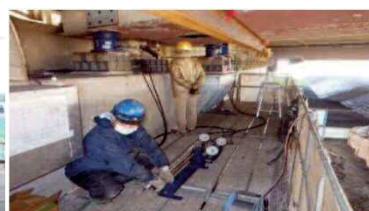
パイルランナーを用いた鋼矢板搬入作業支承取替の為のジャッキアップ
