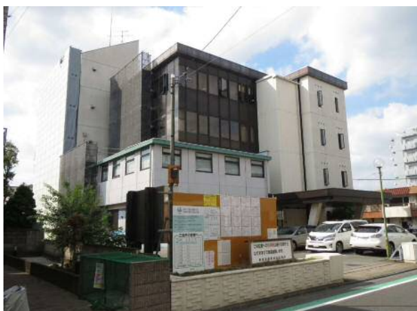
工事中の施設全景
