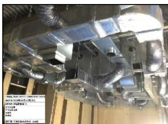
ダクト施工状況
