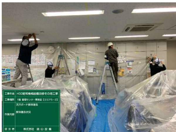
施工状況(空調機交換作業前の執務室養生)
