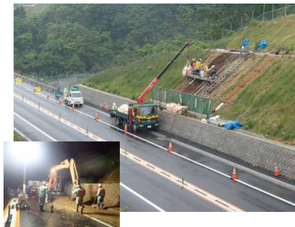
法面崩落復旧作業施工状況
