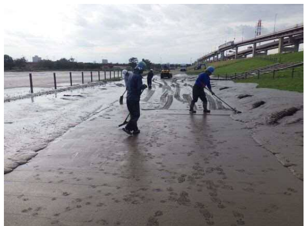
緊急用河川敷道路啓開
