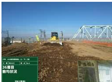
近接盛土施工状況
