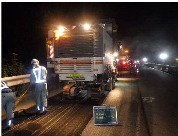
路面切削工 施工状況
