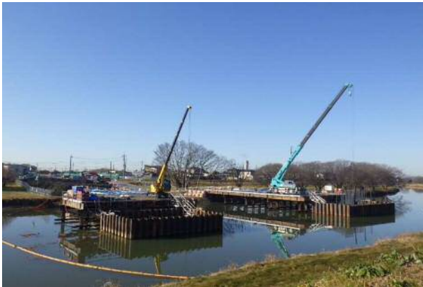
下部工の施工状況
