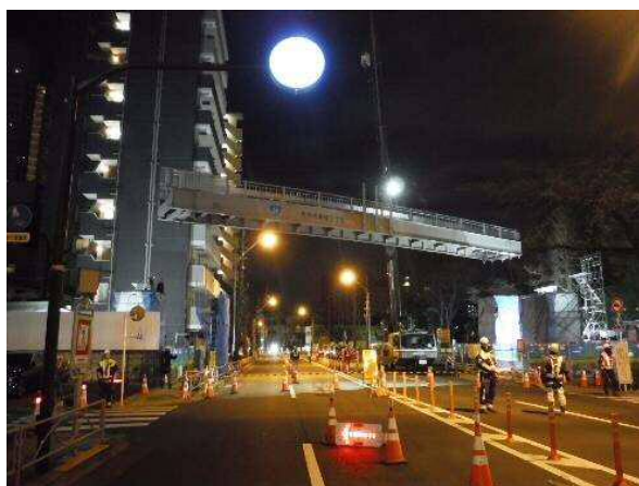
既設橋撤去状況
