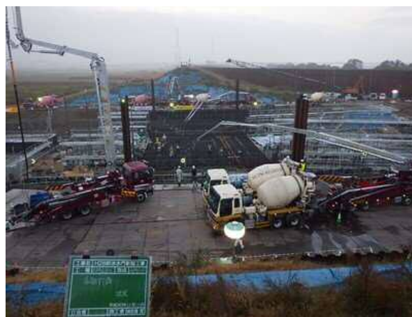
コンクリート打設状況
