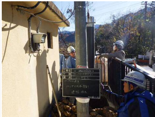
建柱施工状況
