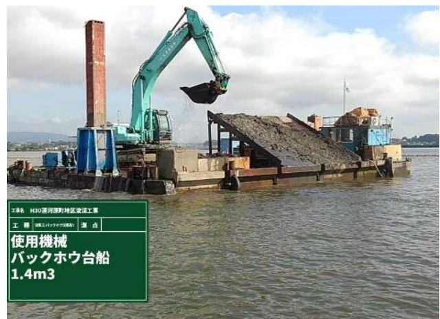
土捨て場での改良BH台船(滑り台式架台設置等)を使用した浚渫土の投入状況
