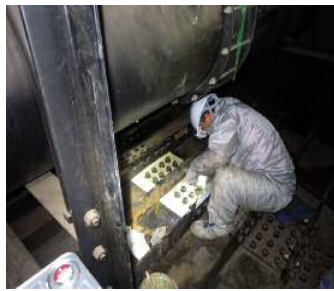
狭隘な箱桁内での断面修復作業
