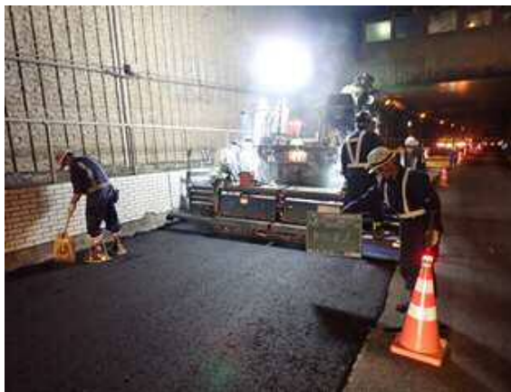
舗装工事施工状況【新宿地区】
