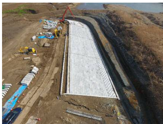
低水(親水)護岸施工状況
