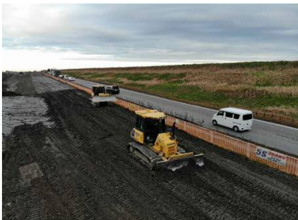
ICT盛土施工状況
