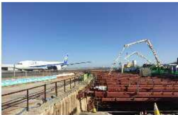
施工状況(構造物工)
