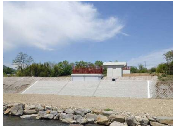
P8橋脚 完成
