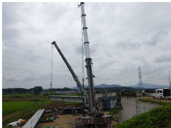
主桁架設状況
