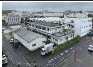
既存庁舎解体前の状況
