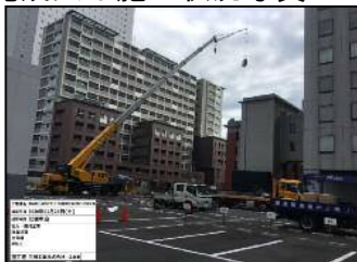
機器搬入状況
