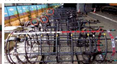
加熱養生シートによるコンクリート養生マーキングによる鉄筋カゴのスペーサー千鳥配置
