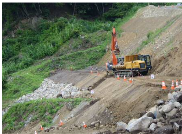
湖面進入路施工状況
