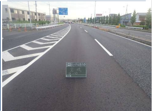
路面補修完成
