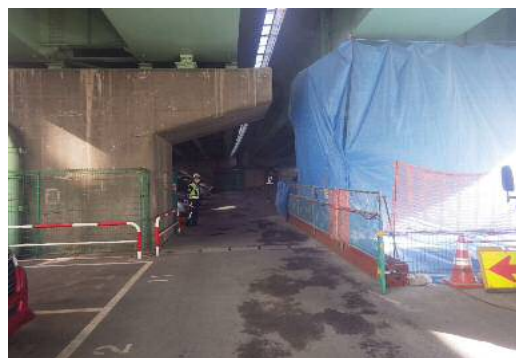
施工状況(ブルーシート養生)
