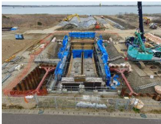
樋管本体施工状況
