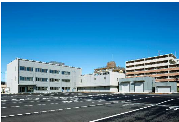
庁舎完成後の外観
