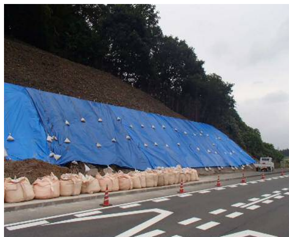
法面崩落応急復旧状況
