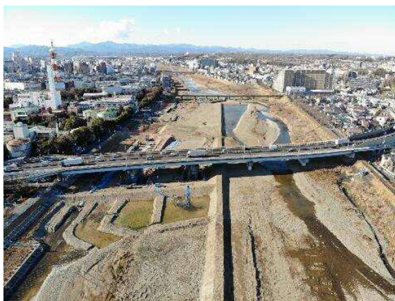
工事用道路施工状況
