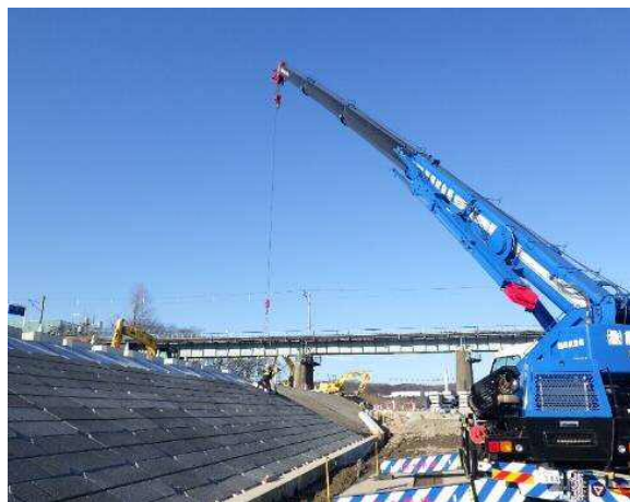
ブロック設置 施工状況
