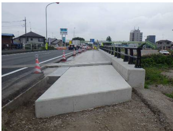
床版踏掛版完成
