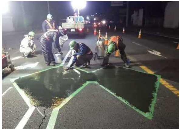
路面補修施工状況
