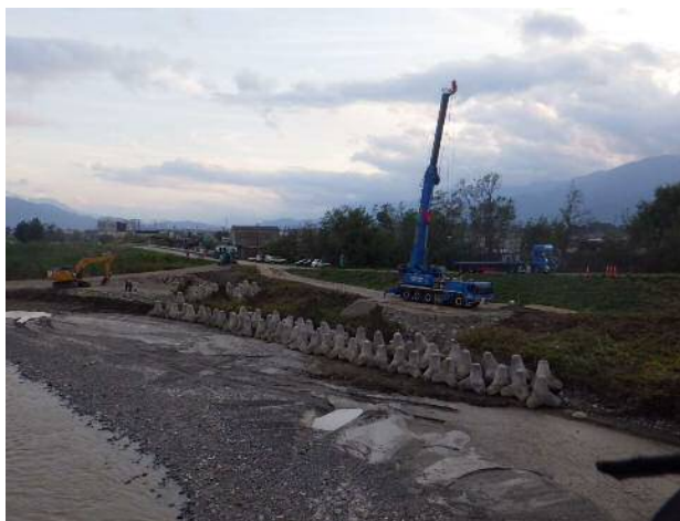
災害緊急対応施工中
