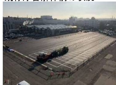
施設を運用しながらの外構工事の状況
