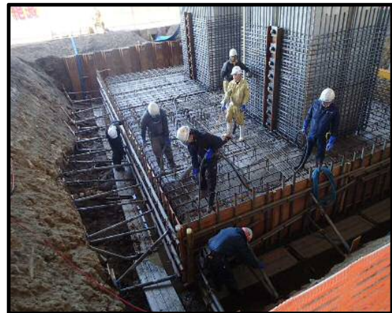
鉄筋組立状況
