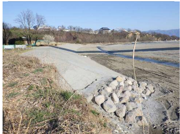
洗掘防止工完成
