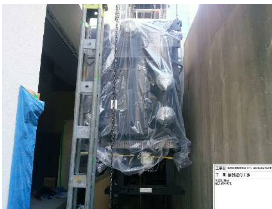
B1F熱源機器搬入状況
