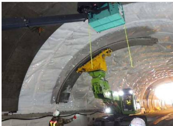
PCL版設置の施工状況
