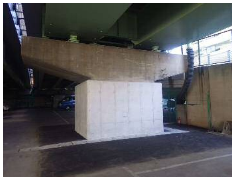
完成(橋脚巻き立て工)
