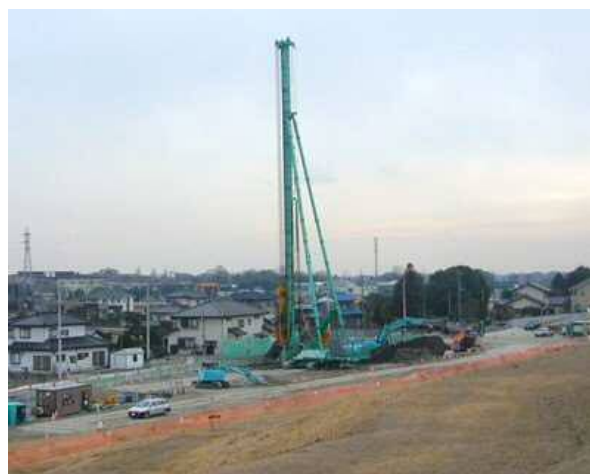
地盤改良施工状況
