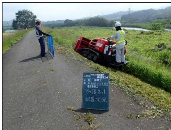
新技術の施工機械での除草状況
