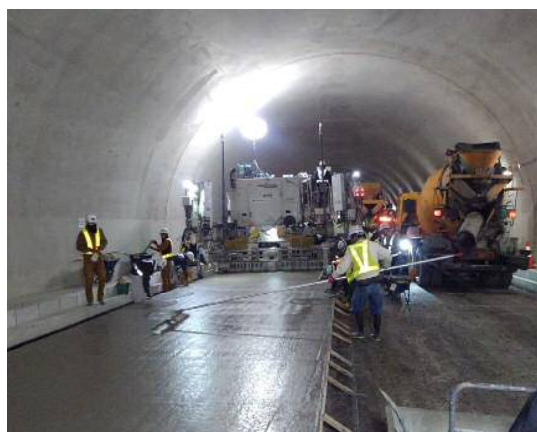
アスファルト(コンクリート)舗装 施工状況
