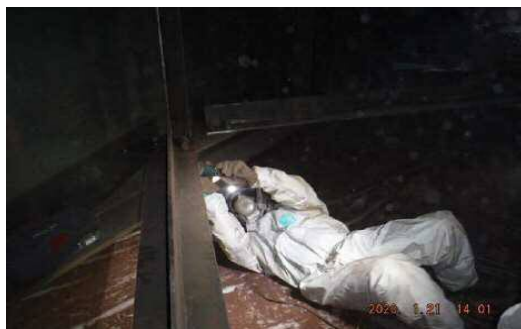
桁下面のケレン作業状況
