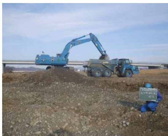
掘削土砂積込運搬施工状況
