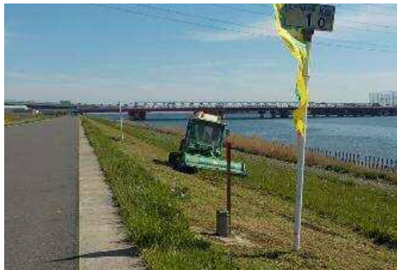
除草施工状況
