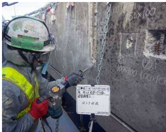
断面修復工(はつり込み)施工状況
