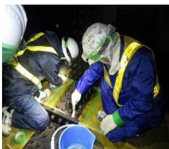
狭隘な箱桁内での断面修復作業
