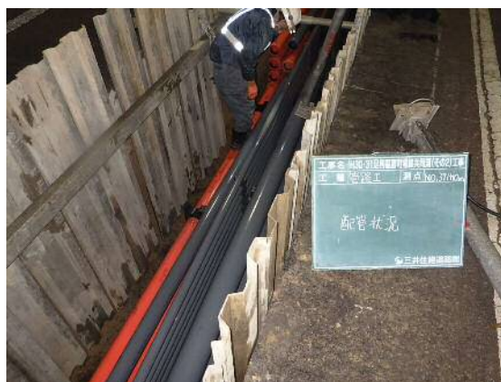
管路敷設 施工状況
