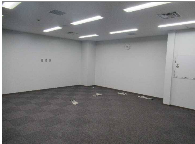
旧食堂を事務室に改修
