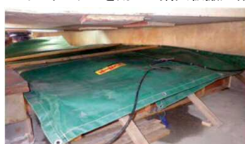
加熱養生シートによるコンクリート養生マーキングによる鉄筋カゴのスペーサー千鳥配置
