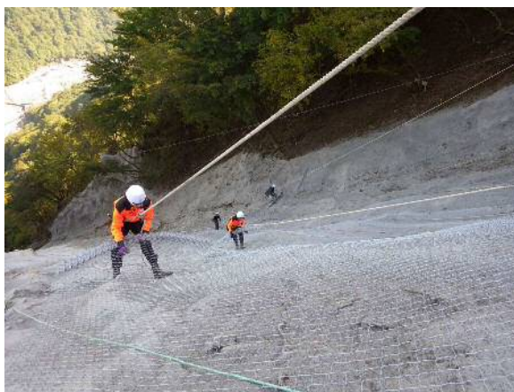
法枠工施工状況
