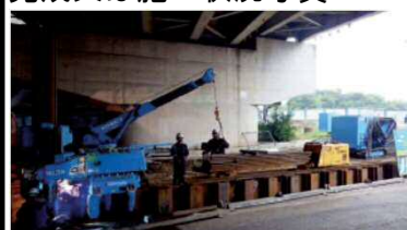
パイルランナーを用いた鋼矢板搬入作業支承取替の為のジャッキアップ
