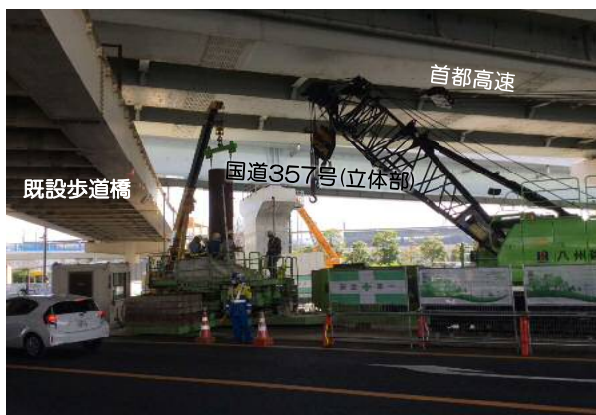
交差点内の鋼管杭施工状況
