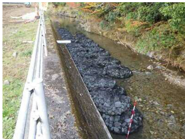
南摩川緊急対応 完成
