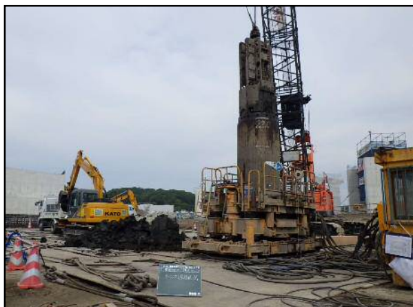
場所打ち杭施工状況
