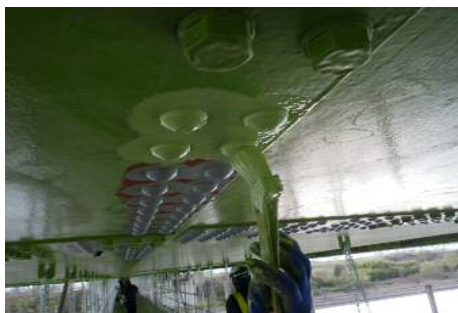
高所に設置した足場での塗装作業
