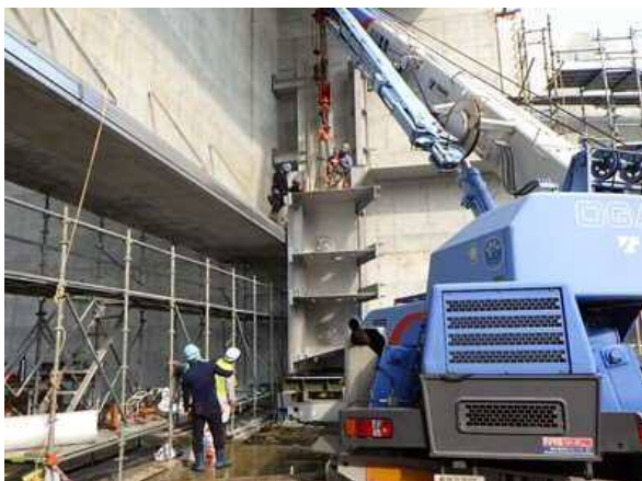
ゲート据付状況
