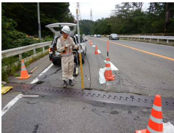
東山橋応急規制状況
