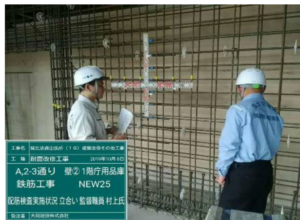
耐震壁施工状況
