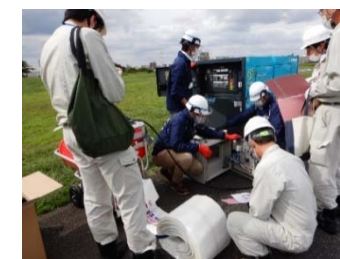
小型移動式排水設備講習状況
