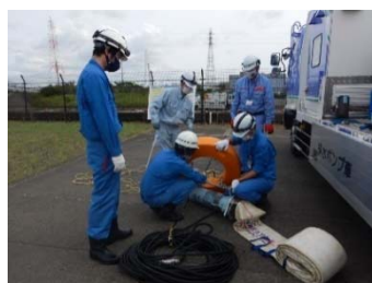
ポンプの組立
