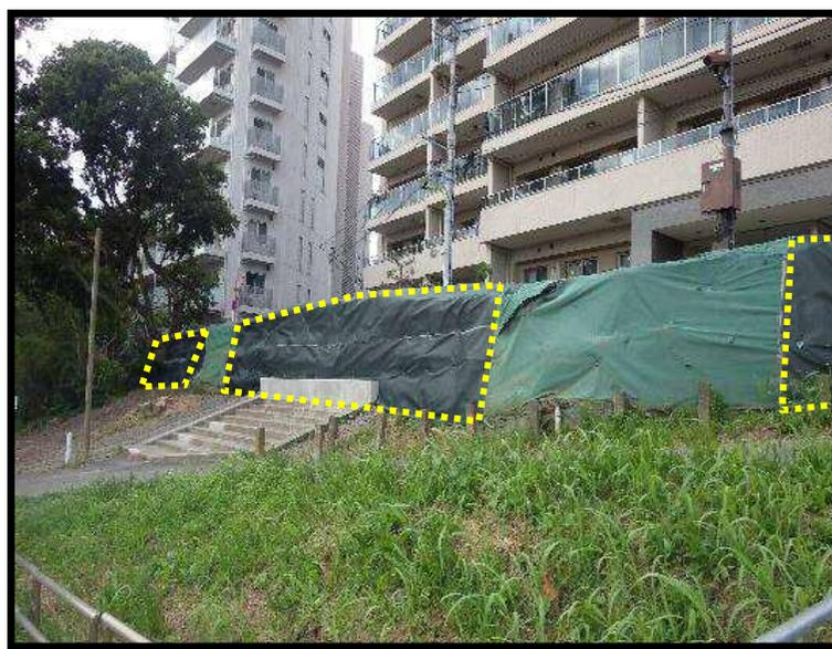
現在設置されている大型土のうに替わる、幅の広い堤防を築造します。
