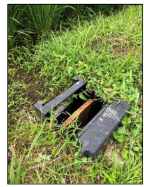
宇都宮市の施工事例
