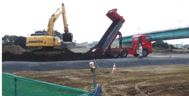
盛土工事状況
