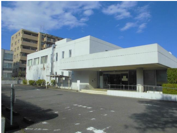
① 倉庫 西側外観
