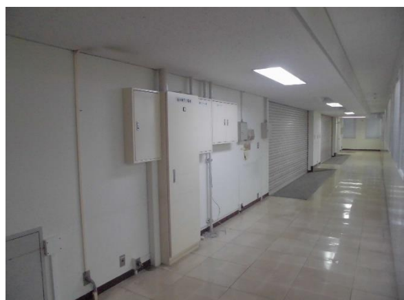
1階事務室(耐震壁新設部)
