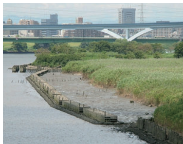
水際に広がるヨシ原は、木工沈床により波の浸食から守られています
