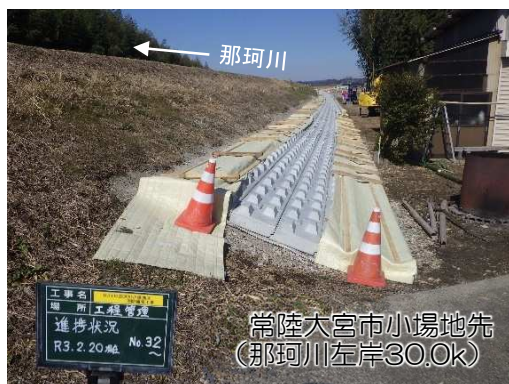
堤防法尻補強
