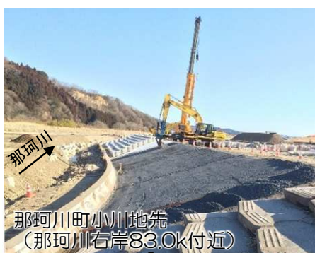
護岸ブロック施工中
