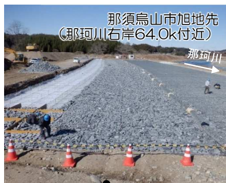
かごマット施工中
