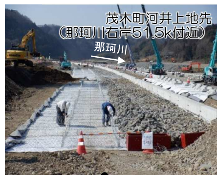
かごマット施工中
