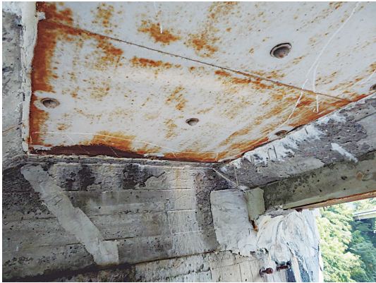
写真－２ 主桁と床版の補強鋼板
