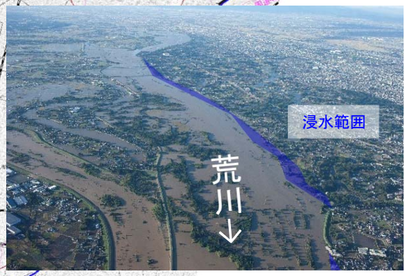
令和元年東日本台風 浸水実績
