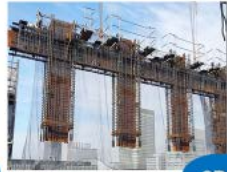
鉄骨鉄筋コンクリート造 (S造+RC造=SRC造)
