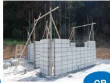
コンクリートブロック造 (CB造)
