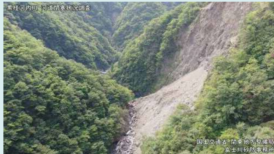
ドローンによる被災状況調査(黒桂河内川)
