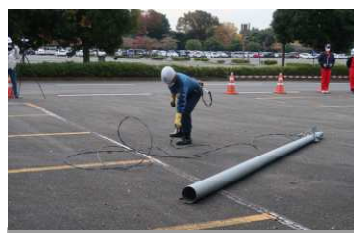
倒壊電柱の通電確認
