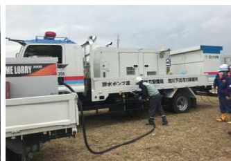
排水ポンプ車への燃料供給
