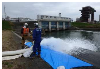
排水ポンプ車による排水
