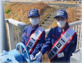
排水樋管ゲート操作
