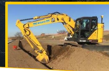
ICT建設機械による施工
