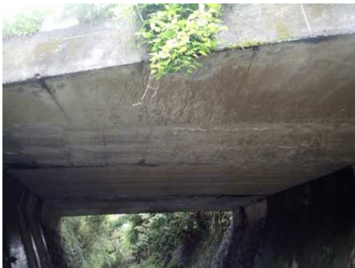
床版下面の状態
