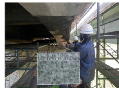
修繕の様子(断面修復)
