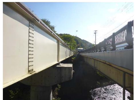
左：対象橋梁（側歩道橋）
