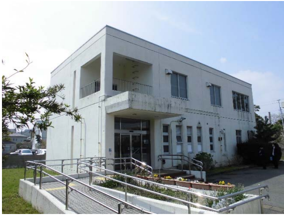
▲①庁舎 北西側外観
