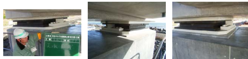
P9 支承完成時の状況（橋脚躯体には損傷なし）
