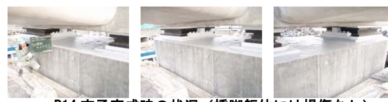
P14 支承完成時の状況（橋脚躯体には損傷なし）
