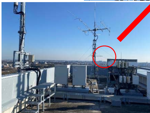
筑波大学 屋上
